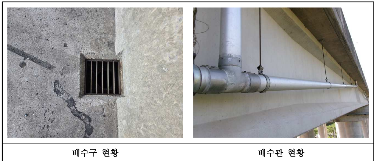
【사진 15.3.22】 배수시설 전경
