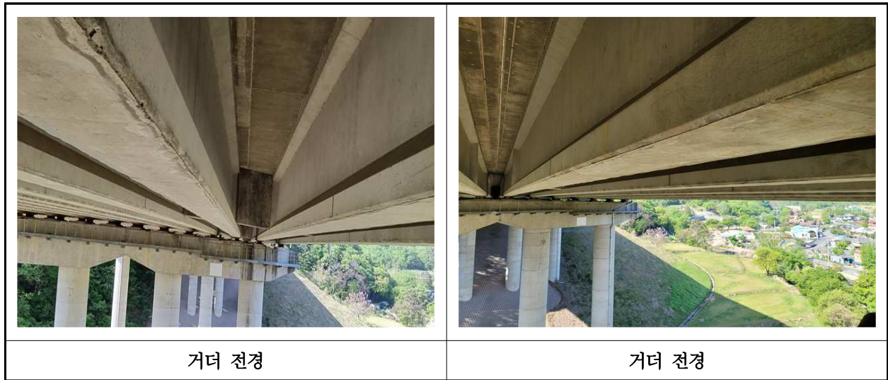
【사진 15.3.4】 거더 전경
