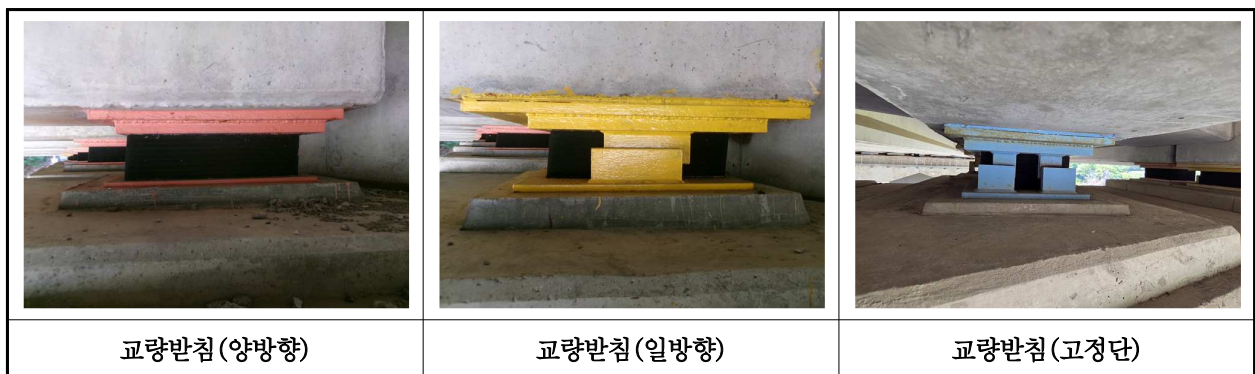
【사진 15.3.13】 교량받침 전경
