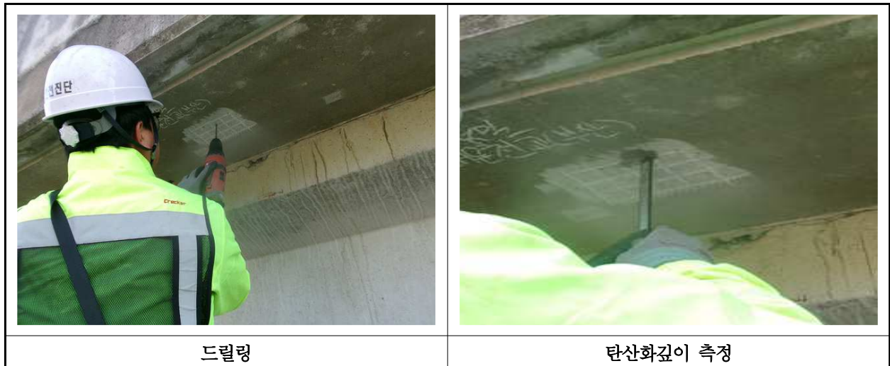
【사진 15.4.3】 탄산화 깊이 측정 현장사진
