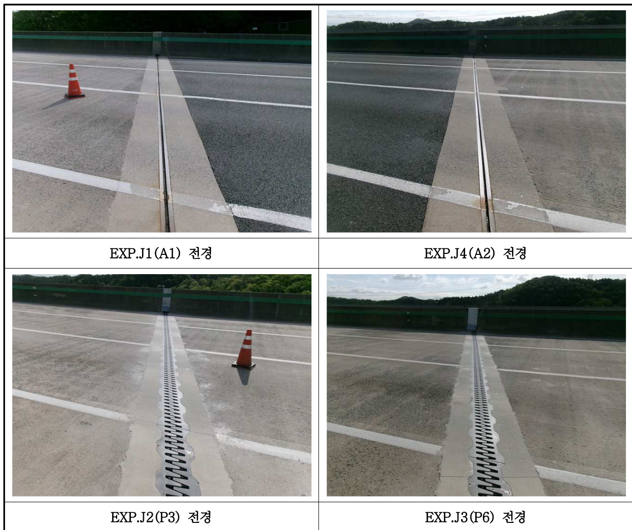
【사진 15.3.17】 신축이음장치 전경
