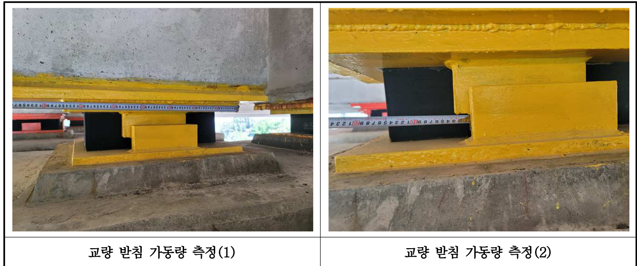
【사진 15.3.16】 교량받침 이동량 측정
