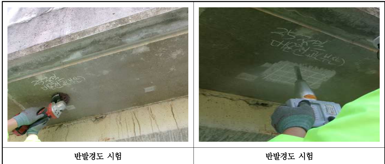
【사진 15.4.2】 반발경도시험 현장사진
