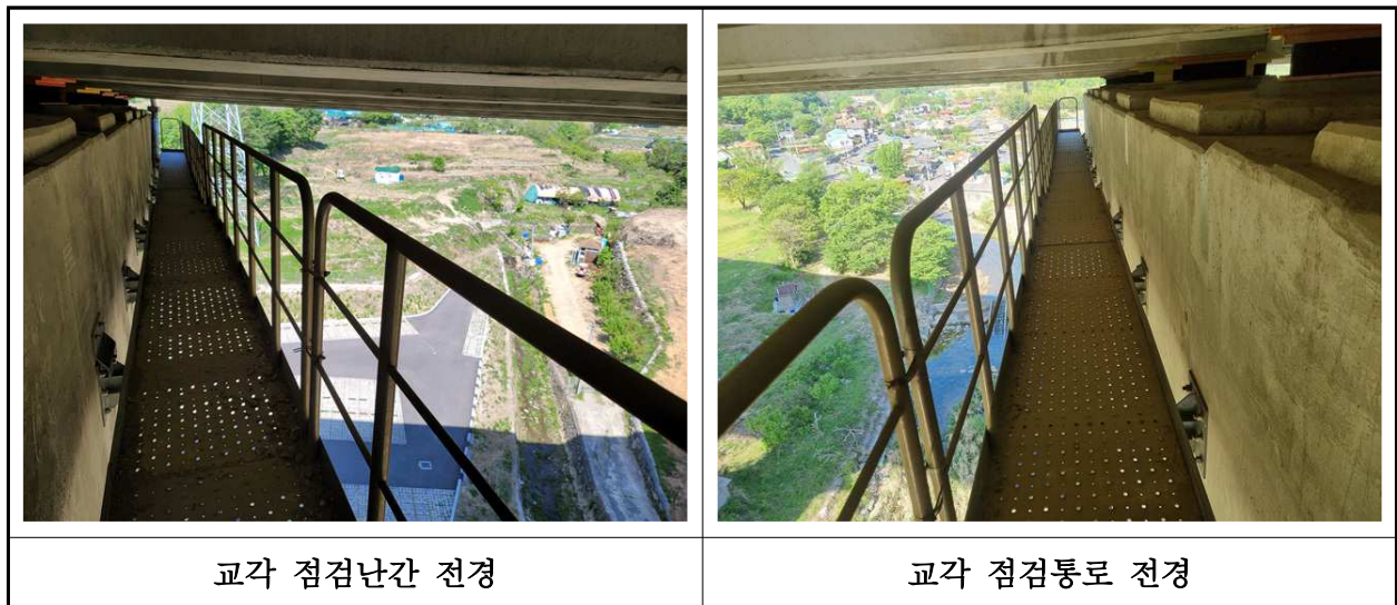
【사진 15.3.26】 교량 점검시설 전경
