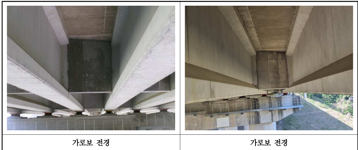
【사진 15.3.6】 가로보 전경
