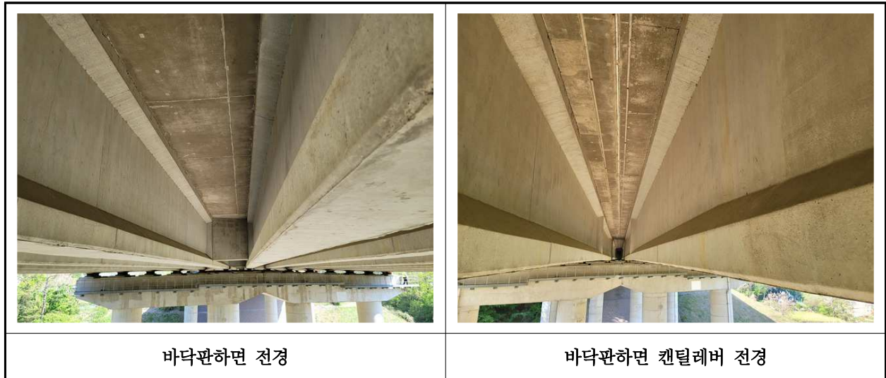
【사진 15.3.2】 바닥판하면 전경
