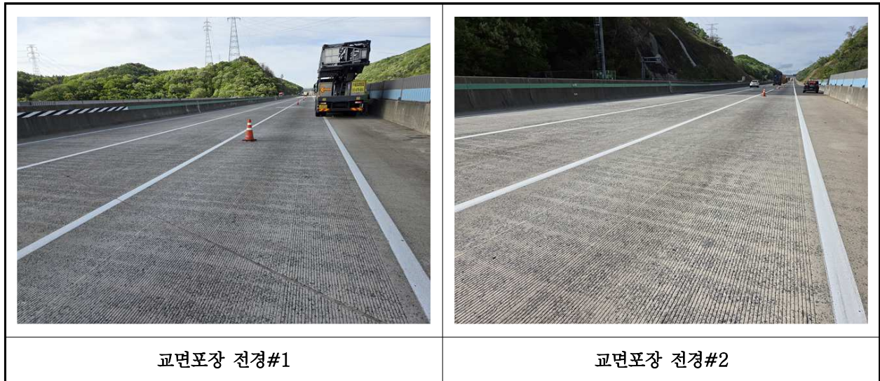
【사진 15.3.20】 교면포장 전경
